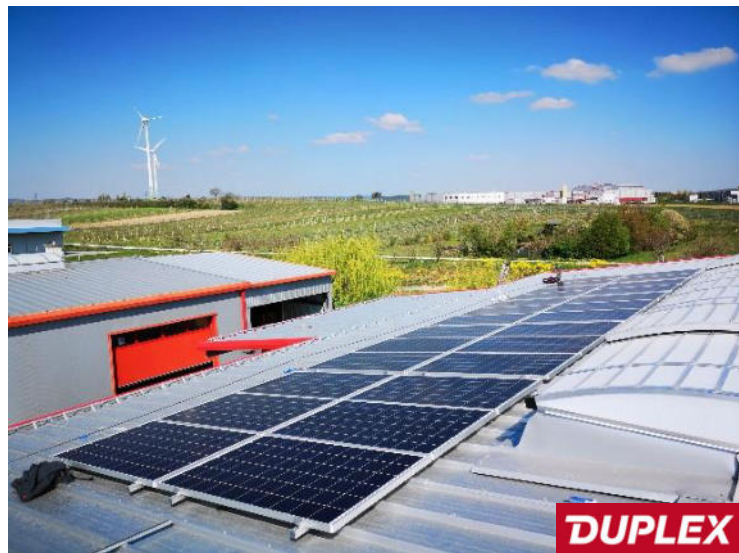
Photovoltaikanlage am Dach des neu errichteten Materiallagers der Firma Duplex in Wolkersdorf
